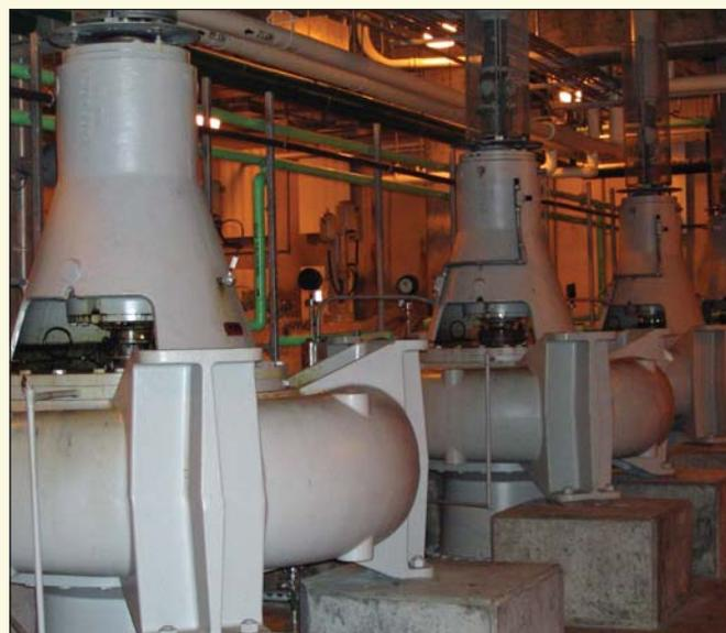
*Le pompe di scarico , con tenute split di 200 mm di diametro, sono in servizio da oltre 12 anni.*
